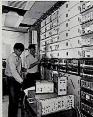
Bild 1: Einmessen der Sendeeinrichtungen im Fernmeldeturm (TE KA DE/PKI-Pressbild)
